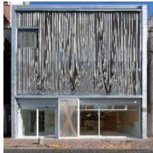
町田本社ビル
