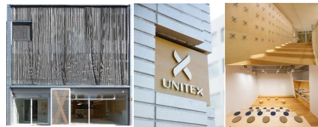
町田本社 ユニテックスビル
